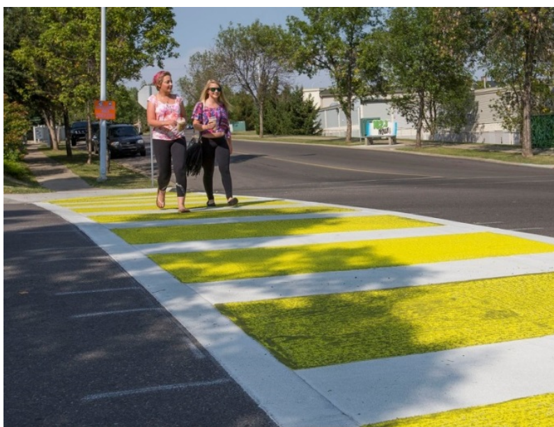
Рис. 6. Приклад експериментального дослідження варіанту флуоресцентного переходу
