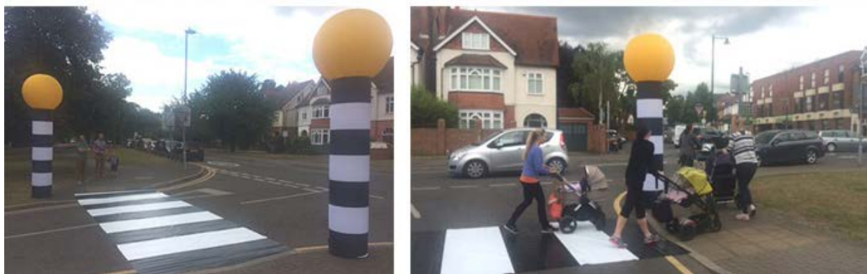
Рис. 3. Приклад застосування люмінесцентних елементів для пішохідного переходу
