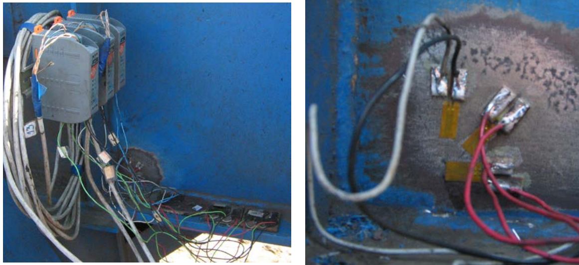
Рис. 2. Монтаж розетки тензодатчиков
