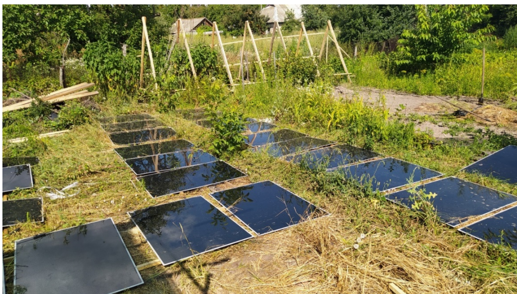
Рис. 9. Процес відновлення сонячних панелей у полі
