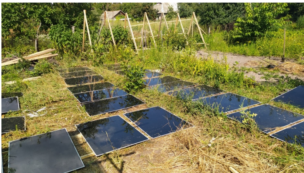
Рис. 9. Процес відновлення сонячних панелей у полі
