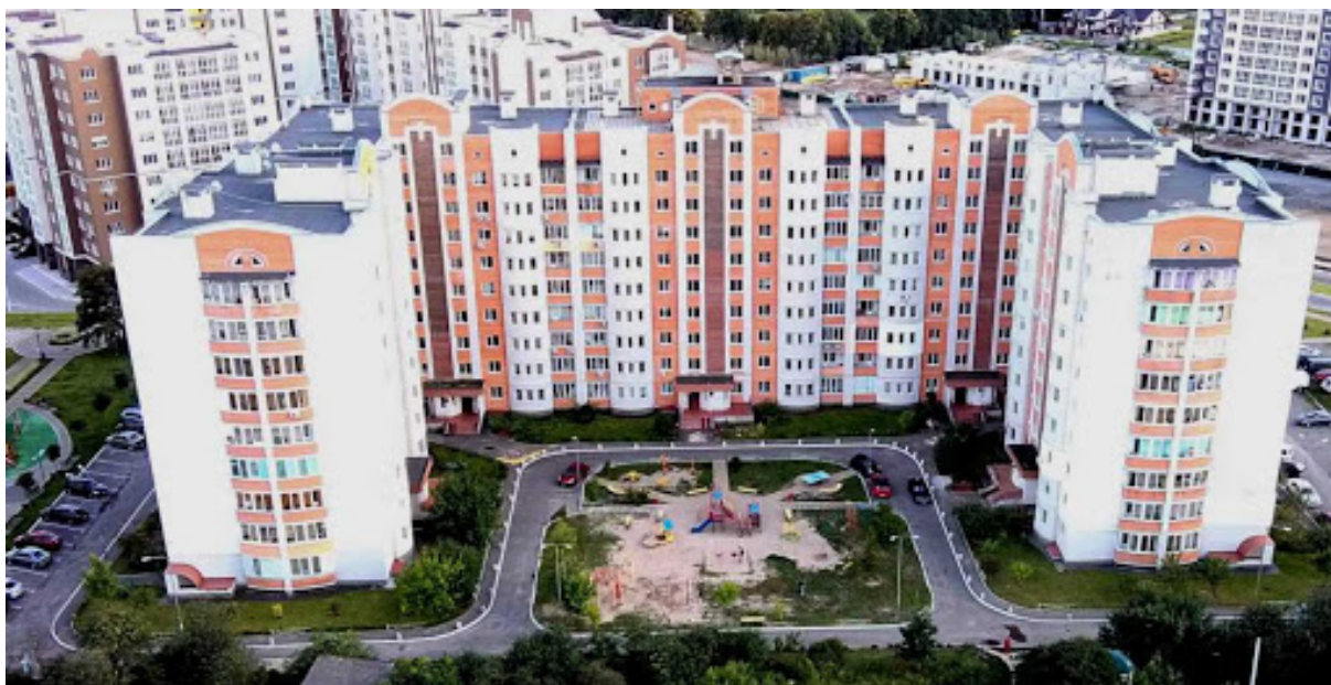
Рис. 1. Загальний вигляд житлової багатоквартирної будівлі П-подібної компоновки
